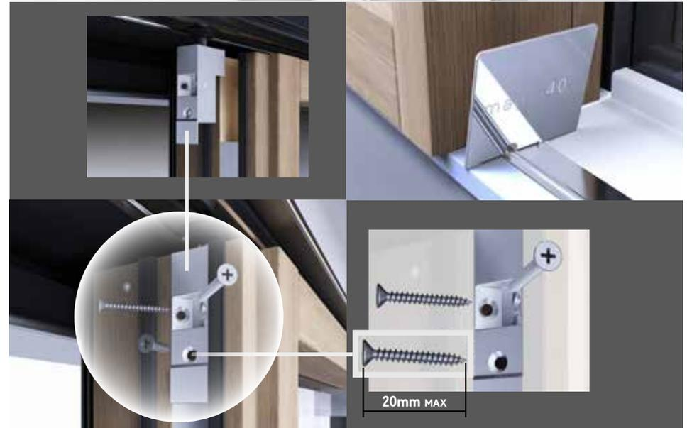
**7** | **Montage des feststehenden Fensters und Anbringung des Aluminiums außen**
