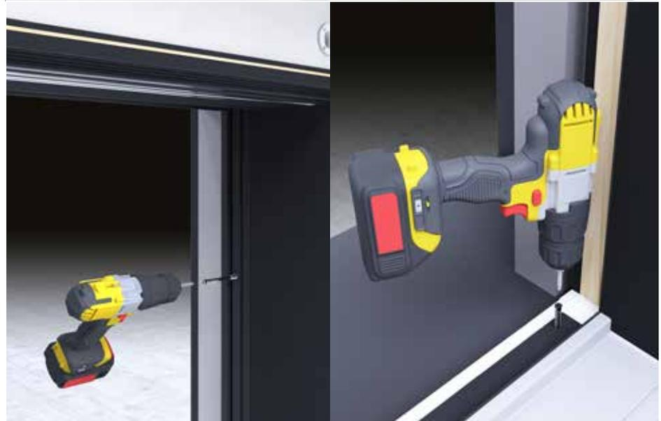
**5** | **Einsetzen des vormontierten Rahmens und Anbringen der Fenster-Distanzstücke**
